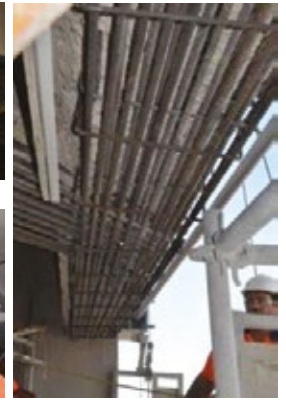
HIDRODEMOLICIÓN
