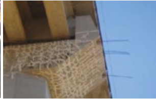
INYECCIÓN DE FISURAS
