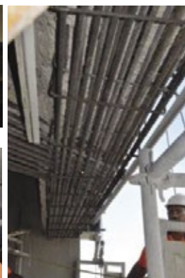
HIDRODEMOLICIÓN
