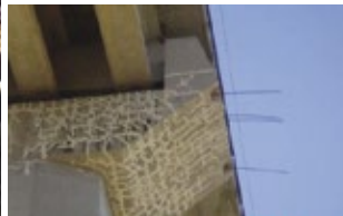
INYECCIÓN DE FISURAS
